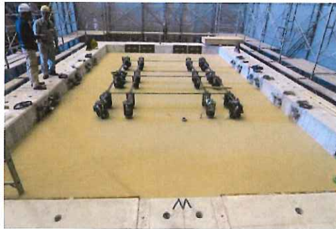
今年度の砂地盤と杭の製作状況
